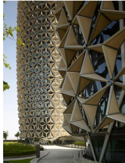
( صورة 33 ) : جزء الواجهة المقابل لأشعة الشمس تم فتح مشربياته لفتح كامل للواجهة اما الجزء الذى يقع فى الظل فتُغلق وحدات المشربية على نفسها للسماح بدخول ضوء النهار
