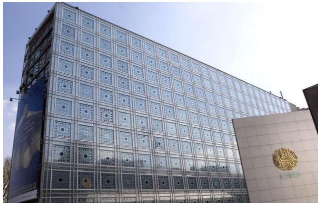
( صورة 22 ) : الواجهة الجنوبية لمعهد العالم العربي مغطاه بشاشة ضخمة من وحدات معدنية مستوحاه من الزخرفة الهندسية الإسلامية والفكرة مستلهمة من المشربية التقليدية
