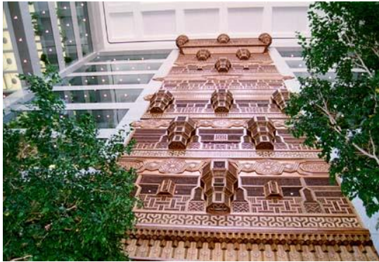
↑ ( صورة 15 ) : استخدام النموذج التقليدى بنفس شكله وخاماته واسلوب التصنيع فى مبنى مقر المنظمات العربية بالكويت
