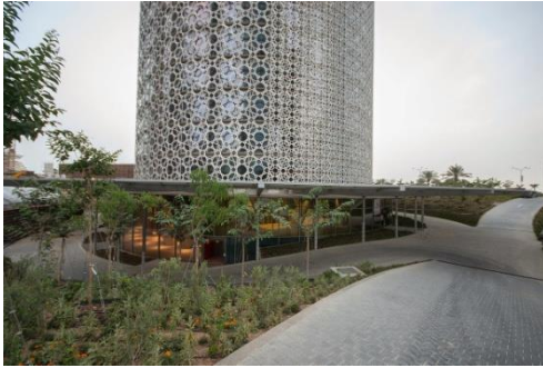
( صورة 29 ) : استخدام الفتحات الكبيرة في الشمال للسماح بكمية ضوء أكبر للدخول من خلالها واستخدام فتحات اصغر في الجنوب للحد من دخول اشعة الشمس المباشرة الشديدة .
